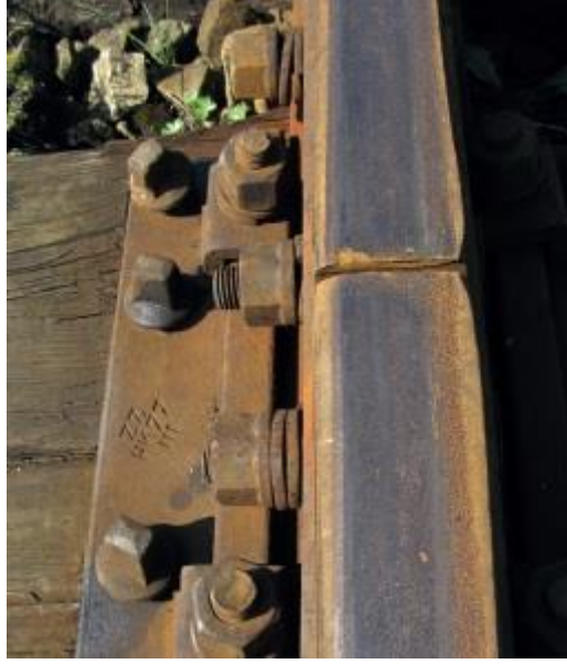
Raylar Arasında Bırakılan Boşluk
